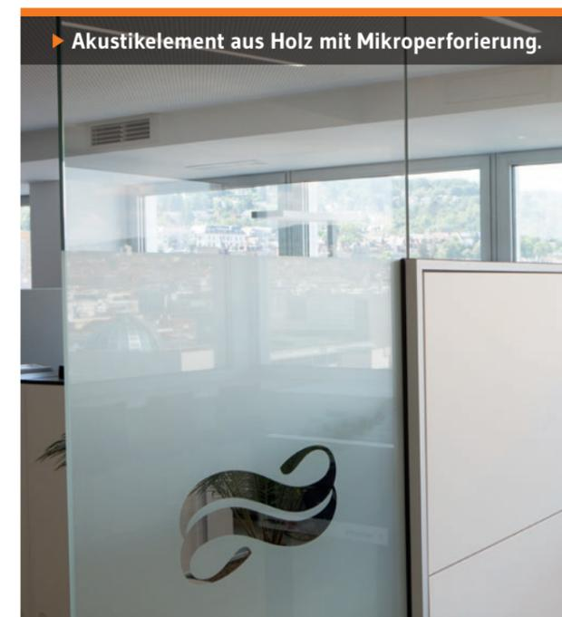
► Akustik Element aus Holz mit Mikroperforierung.
