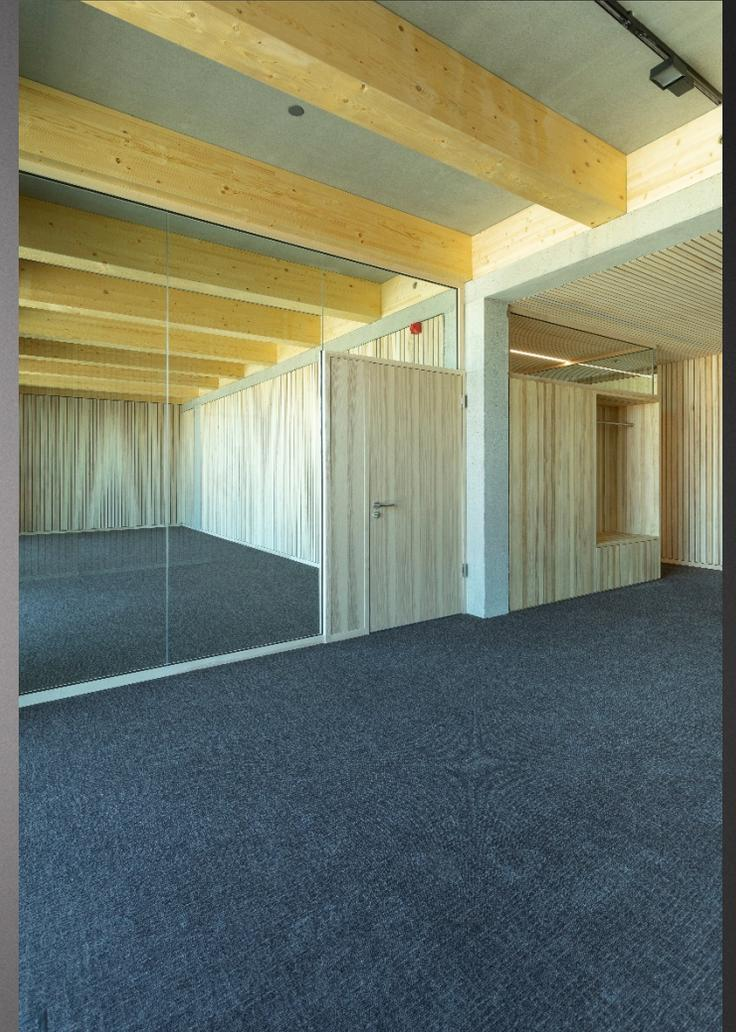
**Lüftungselemente im Türseitenteil integriert**
